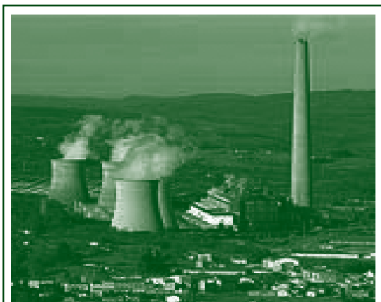
Fig. 38 Centrais como As Pontes están incluídas na IPPC (Fonte: ENDESA)
